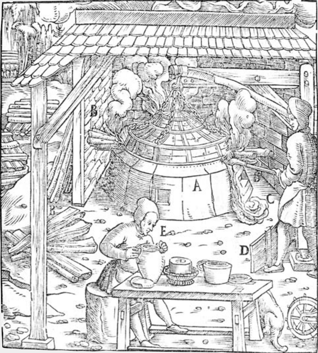
Tavola 2 - La xilografia riproduce una fornace per l'estrazione dell'argento. In particolare a destra si osserva la "spuma argenti" colare dalla fornace. In primo piano, il maestro che dirige il lavoro di estrazione dell'argento è al suo tavolo intento al lavoro e mangia del burro contro il veleno che esala dal catino.
