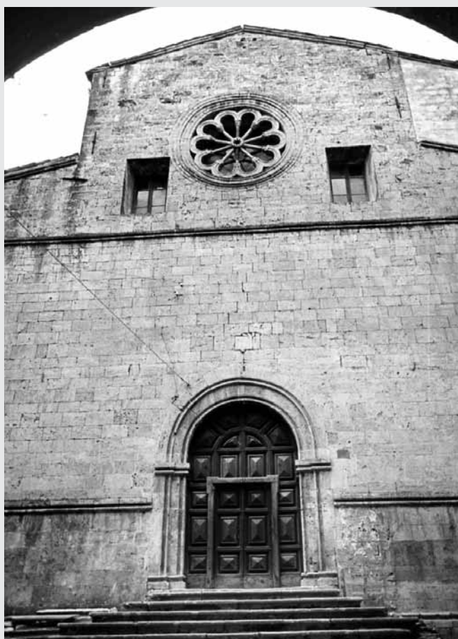
Fig. 1 - Chiesa del Convento di Sant'Angelo Magno.
